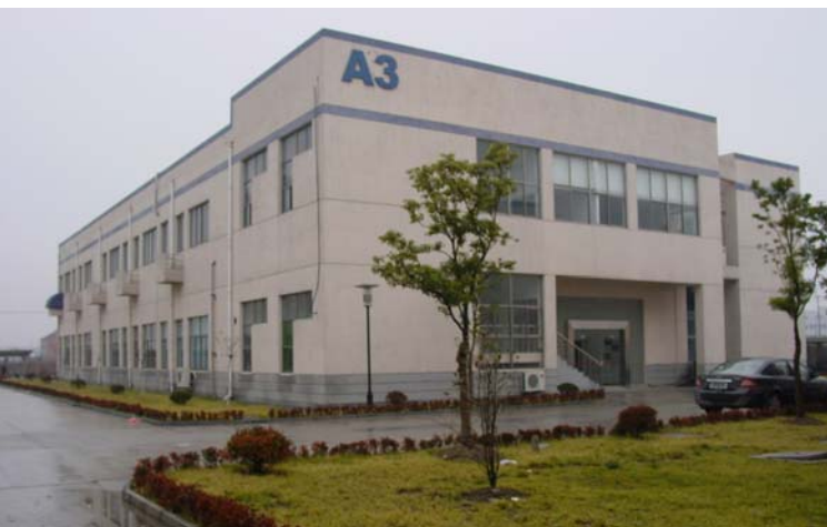
Sede della Bonetti Suzhou Level Gauges & Valves Co. Ltd. a Suzhou, Cina
